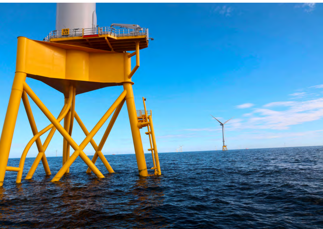
Parc éolien offshore Seagreen (Écosse), en construction.
