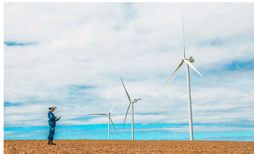
Intervention de maintenance sur le site éolien de Champagne Conlinoise (Sarthe - France).
