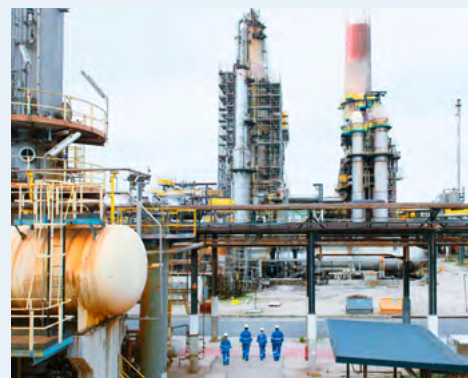
Opérateurs dans le secteur ouest, raffinerie de Grandpuits.
