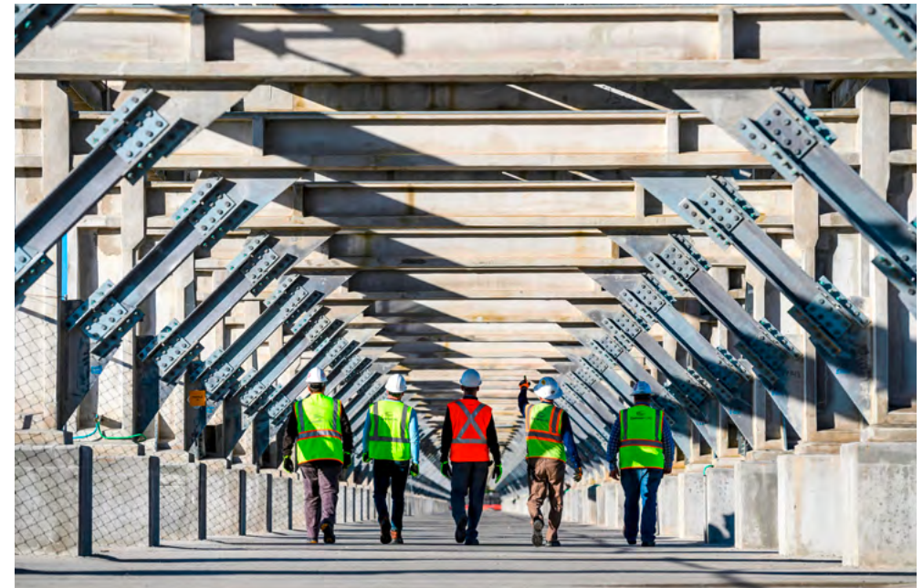
Terminal de liquéfaction (États-Unis).
