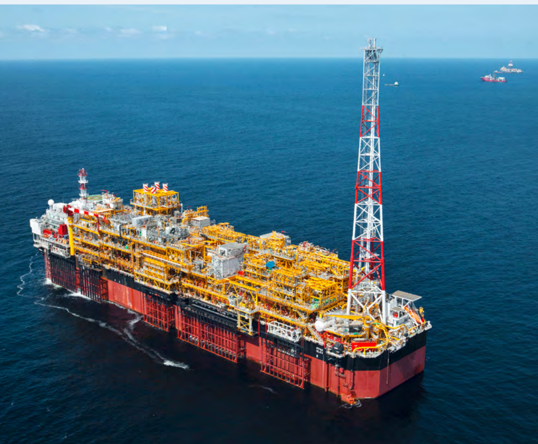
Phase finale d'installation du FPSO, bloc 17, (Angola).
